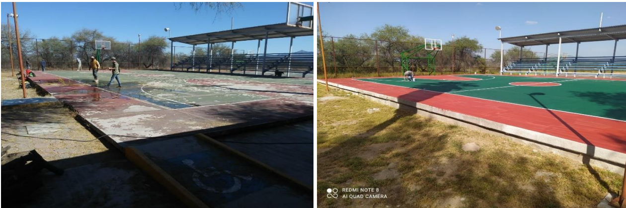
Imagen 4 Mantenimiento a Cancha de Usos Múltiples
