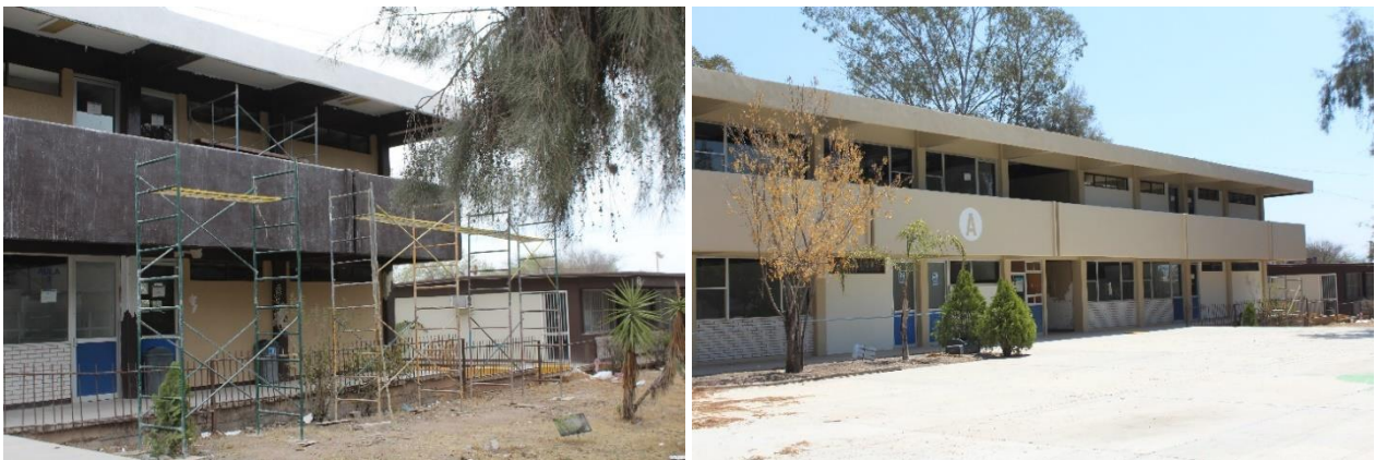
Imagen 7 Mantenimiento a Edificio "A" Aulas
