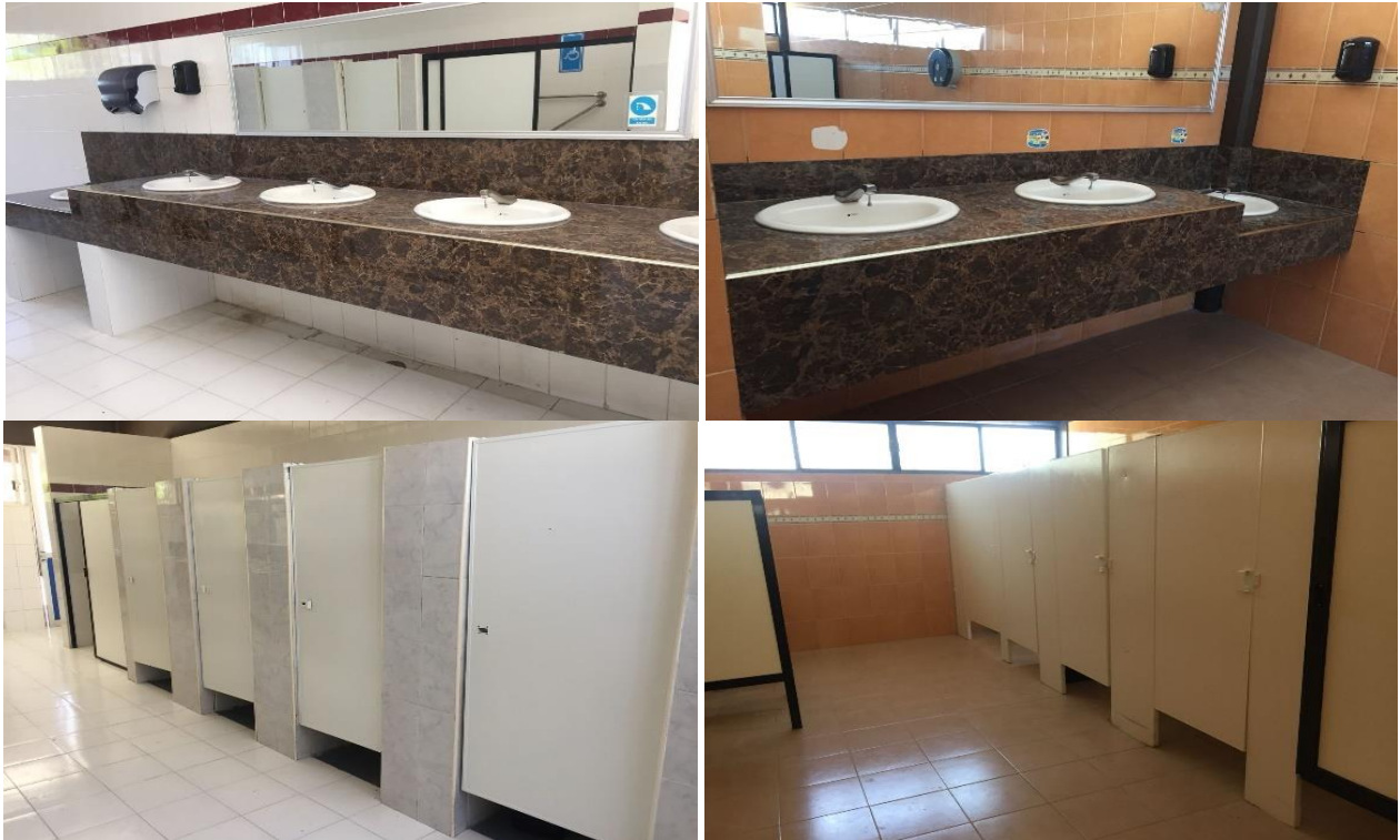
Imagen 6 Mantenimiento Sanitarios Edificio "A" Aulas
