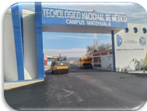
Imagen 26 Fachada de Acceso Sur
