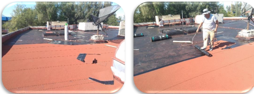
Imagen 23 Impermeabilización del Centro de Información
