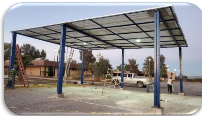
Imagen 25 Rehabilitación de Techo para Autobuses
