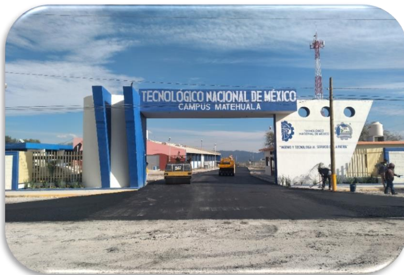
Imagen 28 Pavimentación de Acceso Vehicular (Sur)
