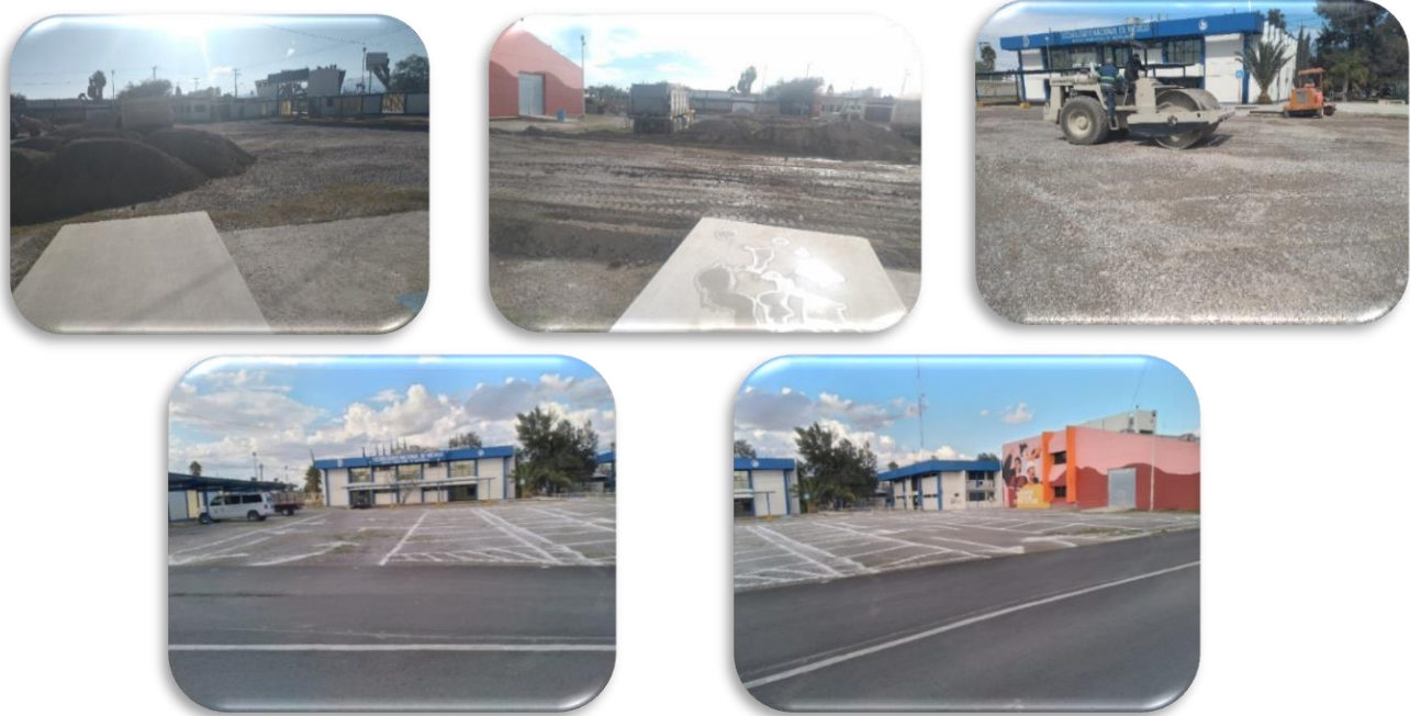
Imagen 27 Mantenimiento al Estacionamiento Administrativo
