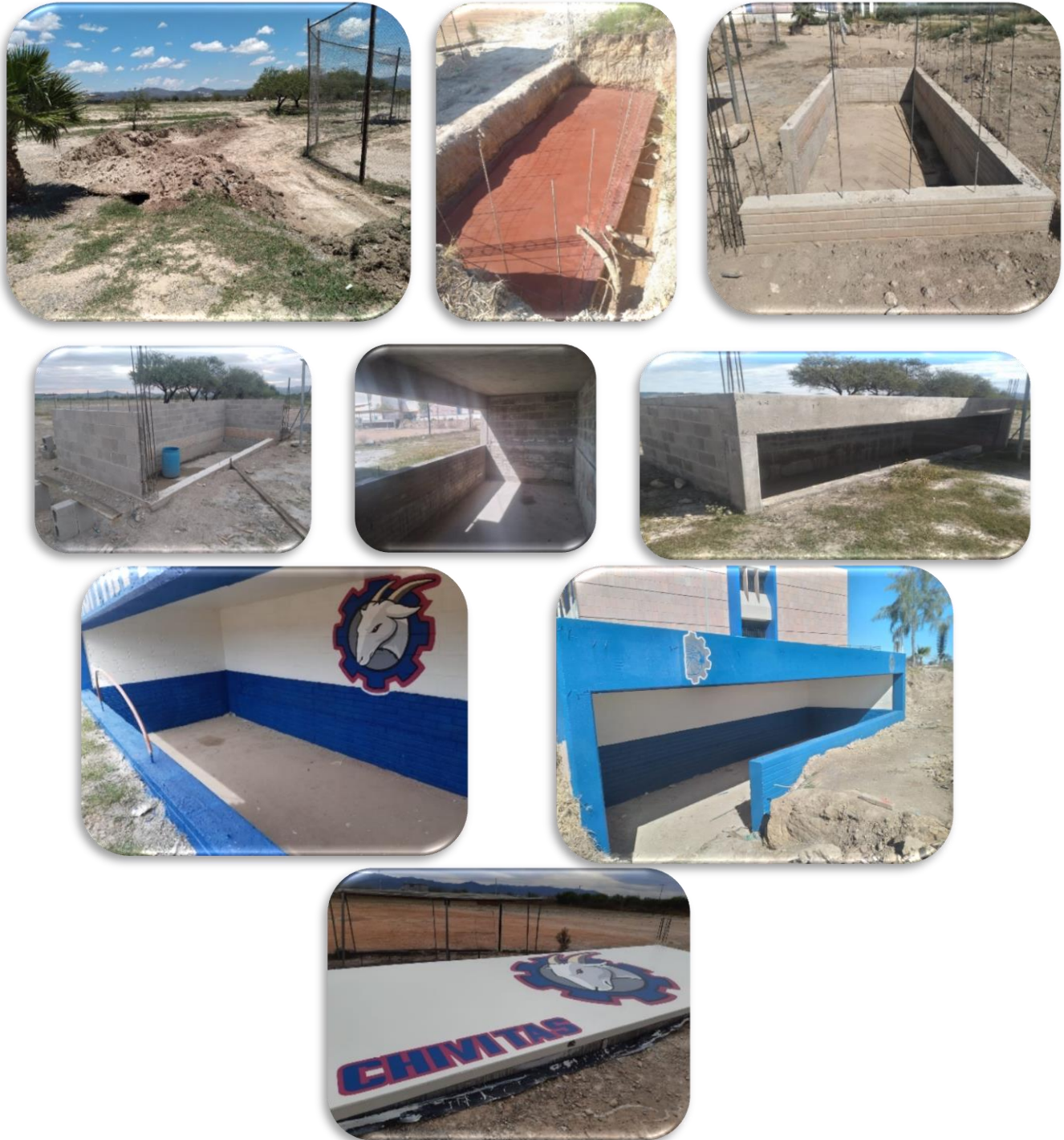
Imagen 29 Construcción de Dogout para campo de Beisbol
