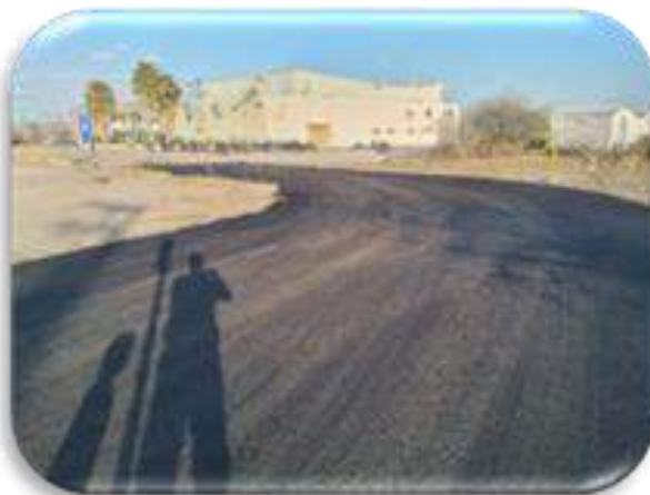
Imagen 24 Suministro y colocación de carpeta asfáltica
