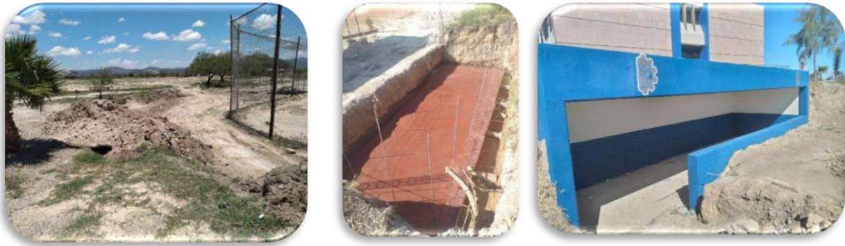
Imagen 29 Construcción de Dugout en campo de Beisbol
