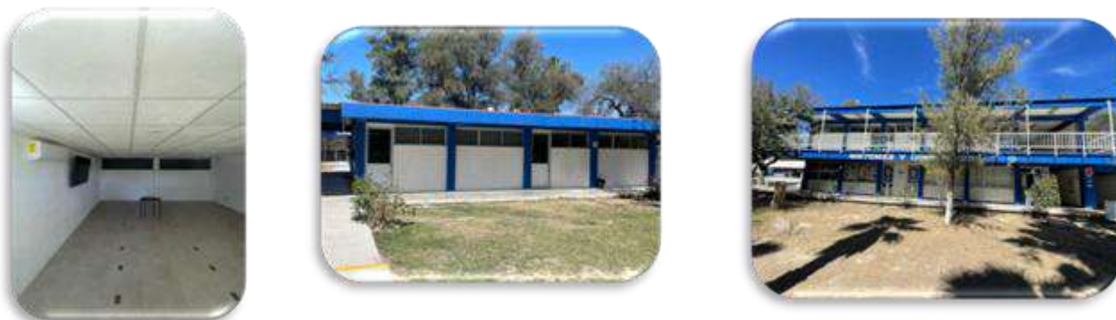
Imagen 21 Rehabilitación de 4 aulas edificio de Sistemas y Computación
