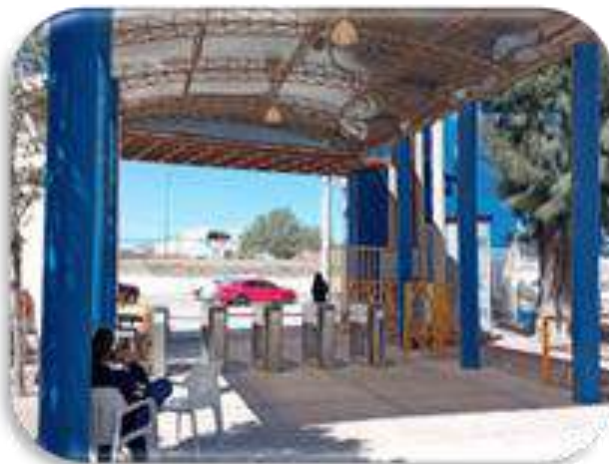
Imagen 20 Barreras de acceso vehicular acceso sur
