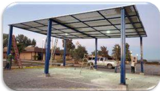
Imagen 26 Construcción de Techado para Autobuses
