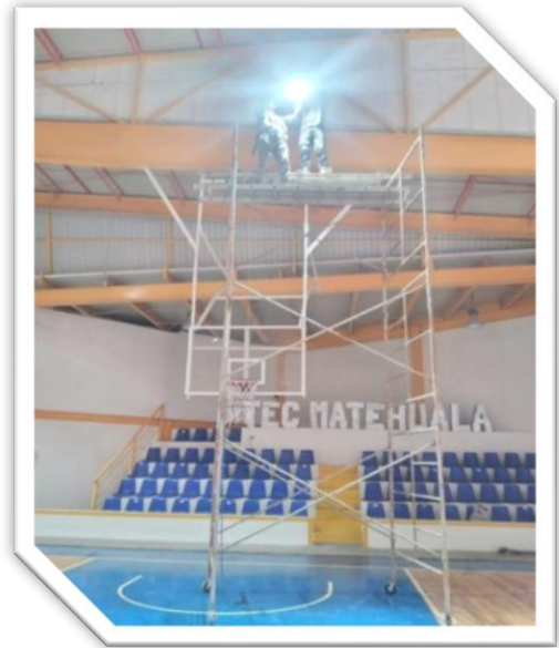
Imagen 18 Instalación luminaria LED
