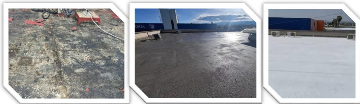
Imagen 15 Rehabilitación de losa del Centro de Computo
