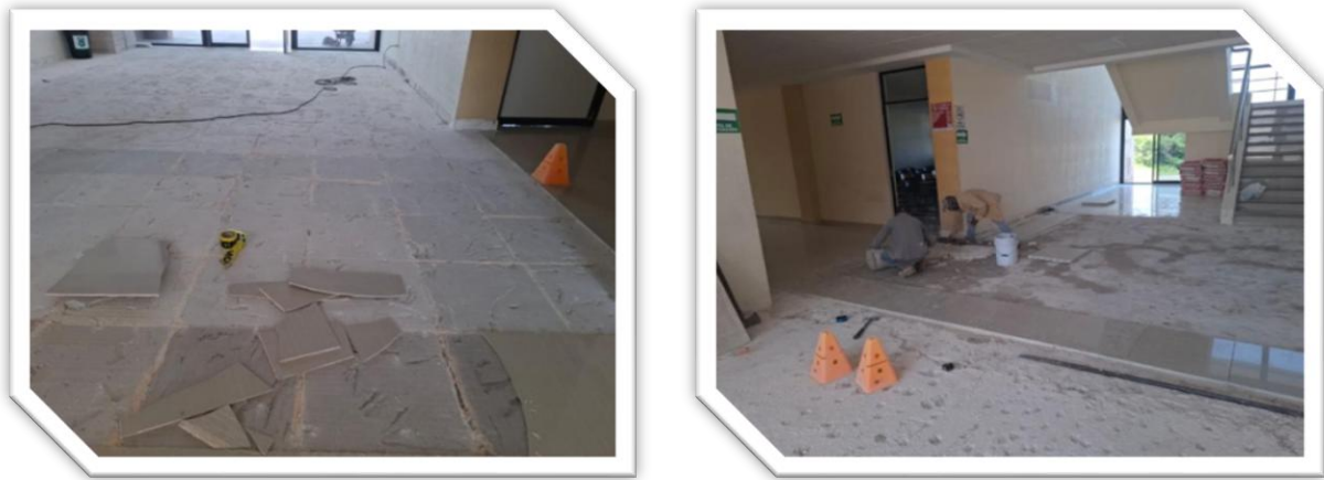
Imagen 14 Rehabilitación de superficie de la Unidad Académica Departamental
