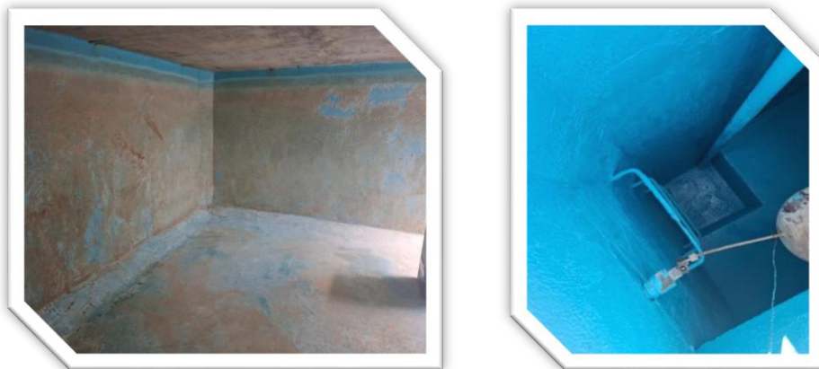
Imagen 19 Mantenimiento de cisternas
